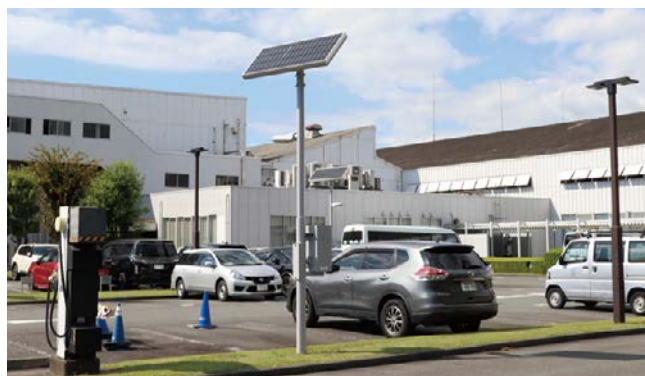
富士本社に設置中の太陽光発電外灯
