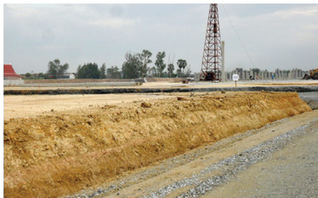
盛り土を行った建築現場
