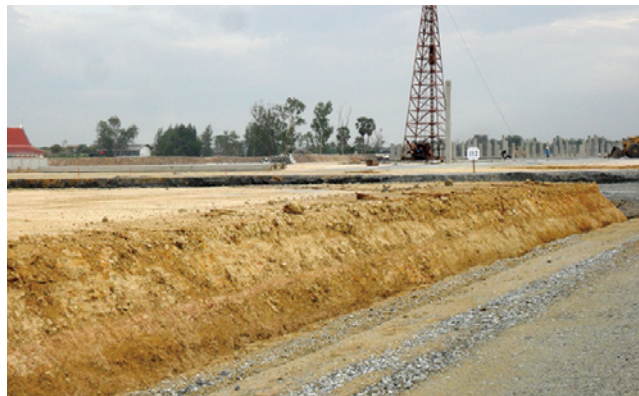
盛り土を行った建築現場
