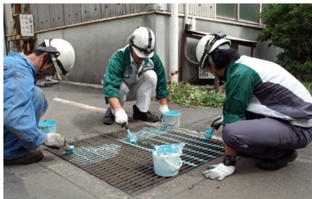
従業員による排水口の色分け作業
