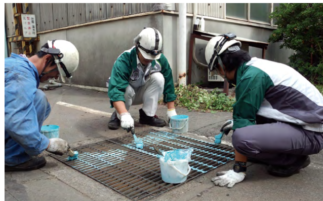
従業員による排水口の色分け作業
