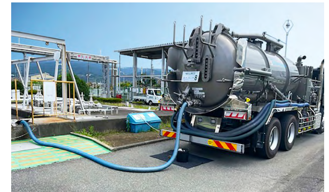
廃棄物専用運搬車両による処理施設への運搬
