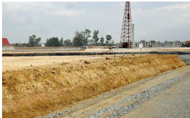
盛り土を行った建築現場
