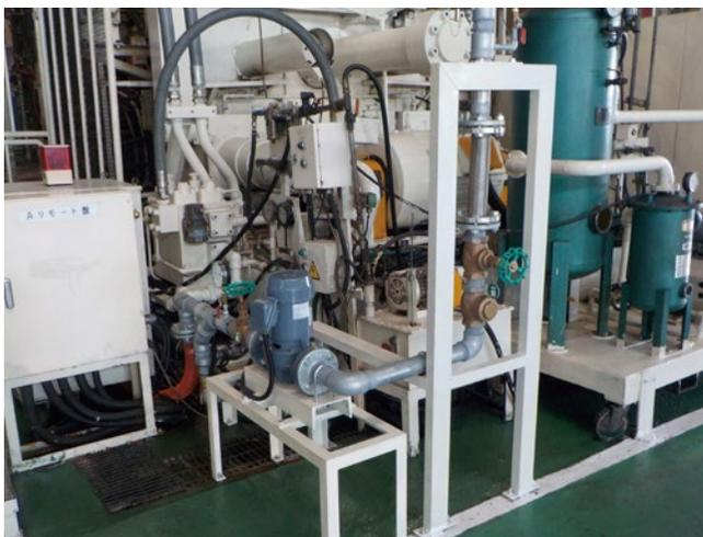
鋳造設備の冷却水循環装置
