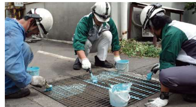
従業員による排水口の色分け作業
