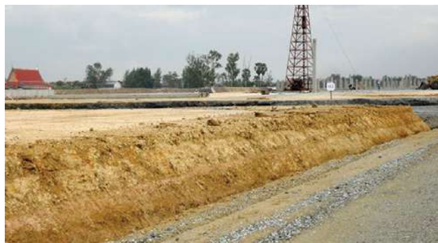
盛り土を行った建築現場
