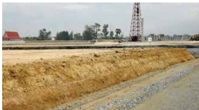
盛り土を行った建築現場
