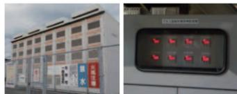
\*NAS電池：液体ナトリウムと液体硫黄、特殊セラミックを利用した蓄電池
