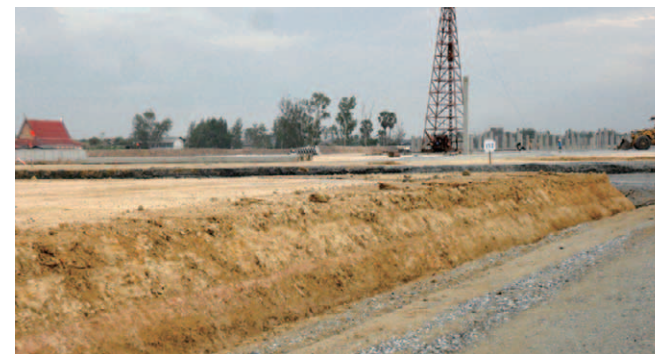
盛り土を行った建築現場
