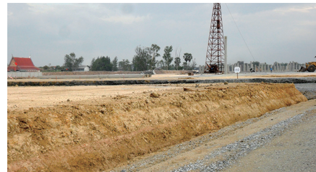
盛り土を行った建築現場
