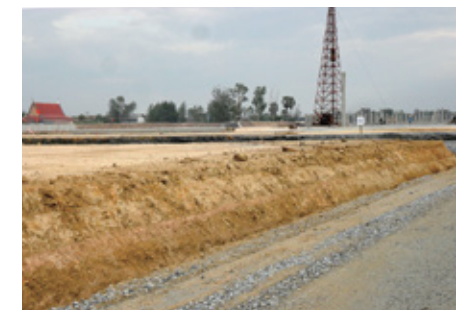
盛り土を行った建築現場
