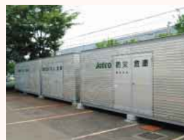
緊急支援物資の備蓄倉庫
